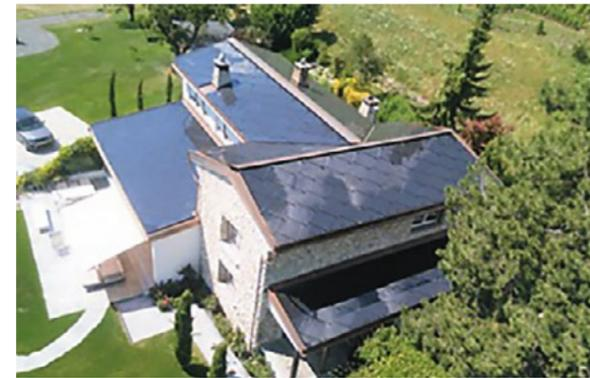
Vor der Sanierung betrug der Energieverbrauch dieses Wohnhauses 73'800 kWh/a, nach der Sanierung nur noch 28'300 kWh/a. Dazu produziert die vollintegrierte Dachanlage 30'600 kWh/a.
