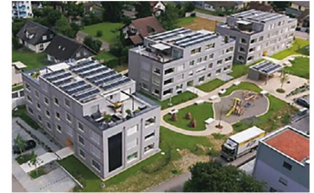
Der Gesamtenergieverbrauch dieser Wohnanlage ist mit 130'164 kWh/a bei einer Energiebezugsfläche von 4'385 m<sup>2</sup> oder 29.8 kWh/am<sup>2</sup> tief. Die Solaranlagen produzieren 157'766 kWh/a, was die Min. P-Eco/PlusEnergie-Siedlung einen Eigenversorgungsgrad von 123% erreichen lässt. Also grosser umweltgerechter Komfort zu marktüblichen Mieten.
