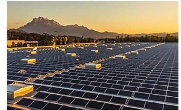
Das Solardach dieses Logistikzentrums in Perlen im Kanton Luzern ist so gross wie die Fläche von sechs Fussballfeldern. Die perfekt ins Dach integrierte 6.4 MW starke Solaranlage produziert 7.33 GWh/a Solarstrom. Das ist mehr als doppelt so viel, wie das Verteilzentrum selbst verbraucht. Zum Vergleich: Liechtenstein weist ein Solarpotential von 150 bis 260 GWh/a aus und will lediglich einen Zubau von 48 GWh/a bis 2030.
