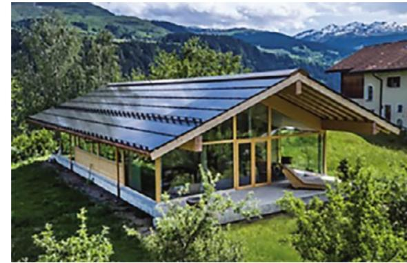
Das perfekt dachintegrierte PV-System mit 48 kW Leistung produziert 40'200 kWh/a Strom. Dank guter Dämmung, effizienten Haushaltsgeräten und LED-Beleuchtung beträgt der Gesamtenergieverbrauch nur 4'900 kWh/a.
